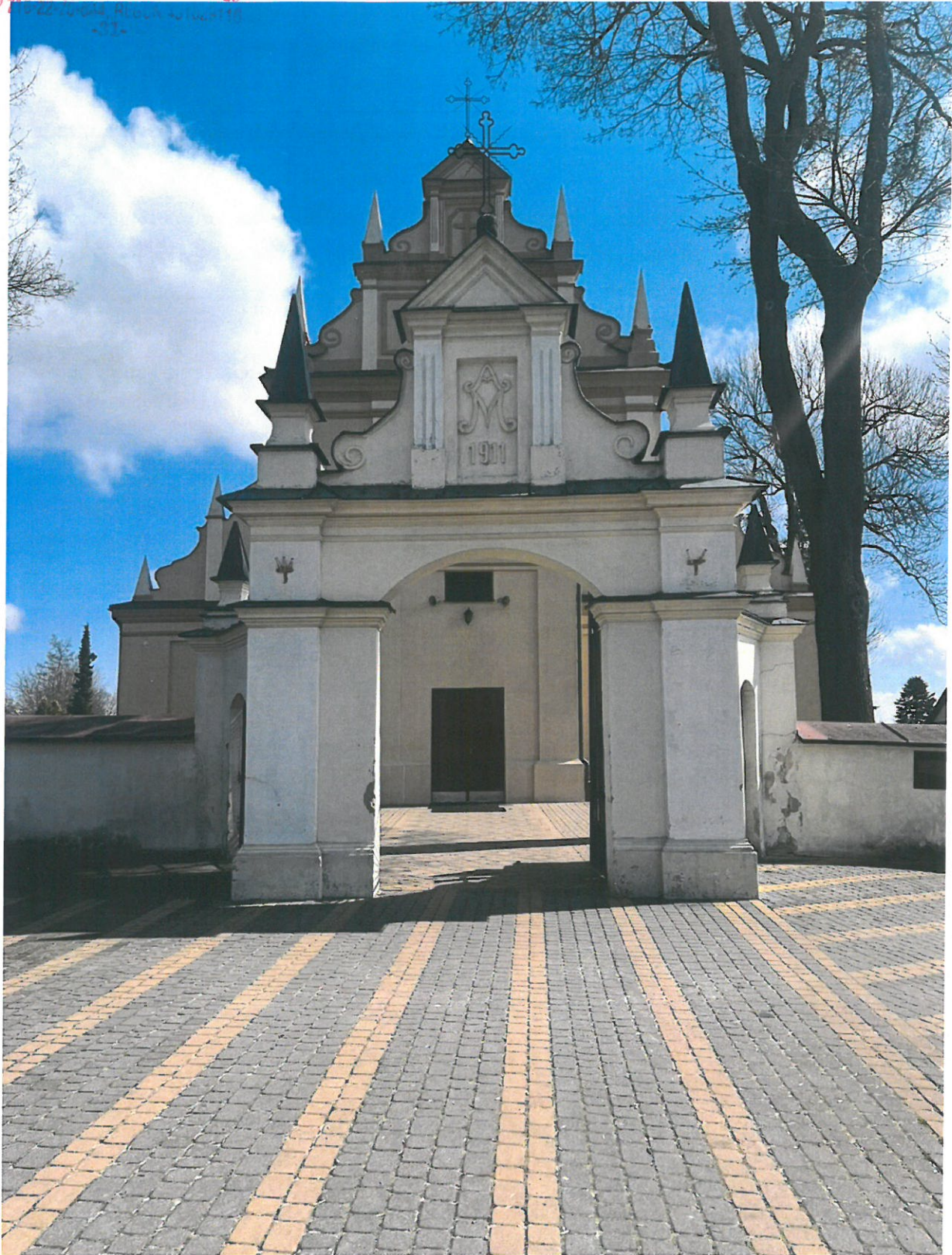
Zdjęcie 1. Widok na główną bramę wejściową z perspektywy ul. Żabiej
