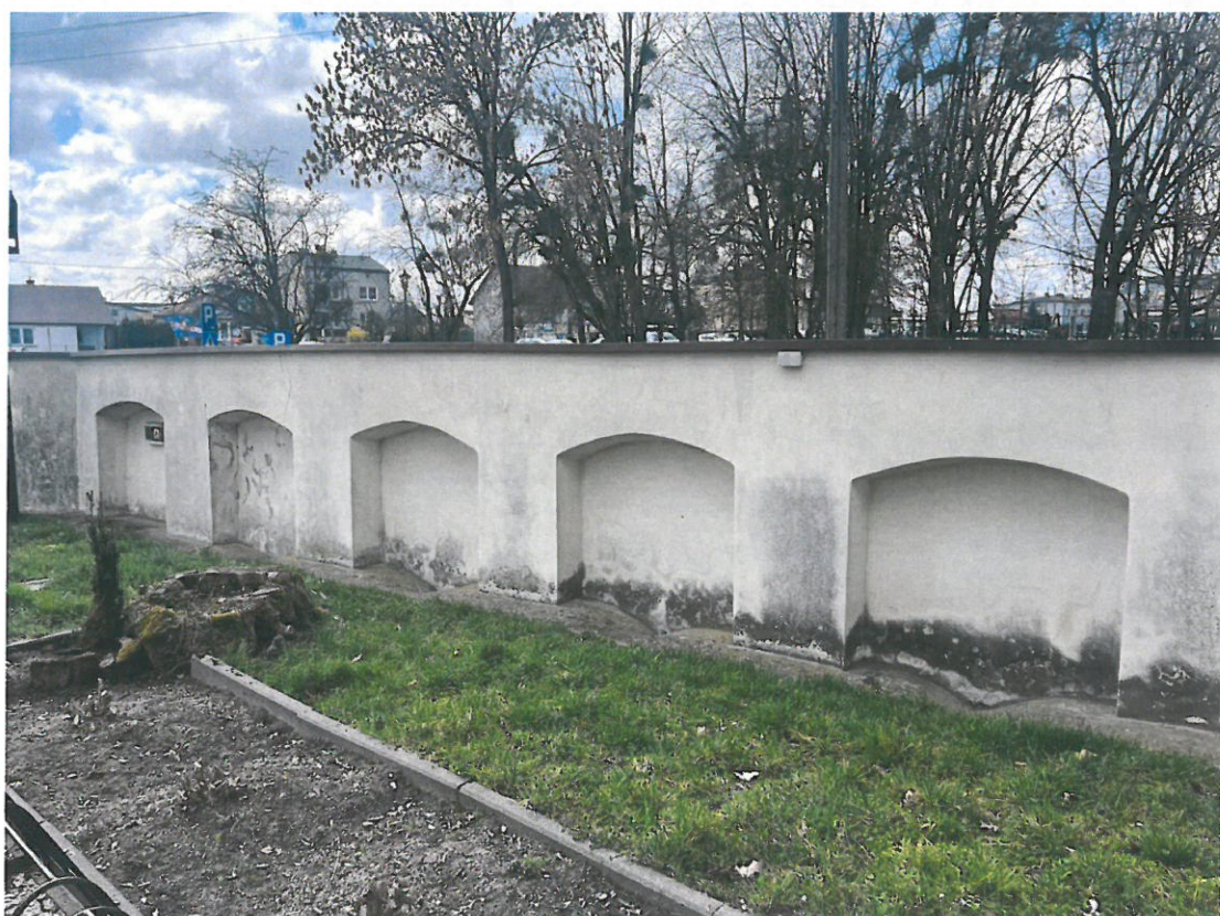
Zdjęcie 4 i 5.(od góry) Widok na fragment muru wzdłuż ulicy Żabiej z perspektywy kościoła
